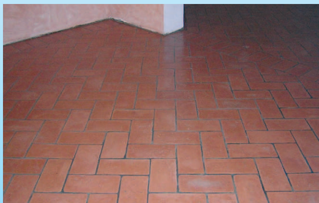
COD. PAVI. 174 • Pavimentazione interna, semilevigata a lavorazione spina di pesce
