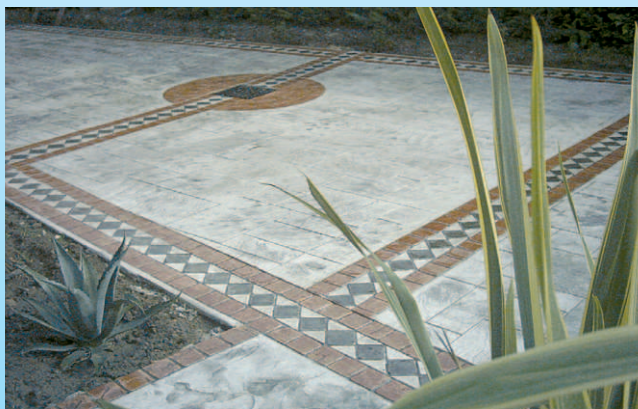
COD. PAVI. 114 • Pavimentazione con mattoni di vario formato con greca al bordo
