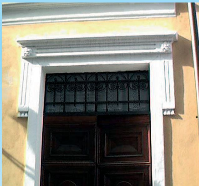
COD. CONT 026 • Particolare di porta
