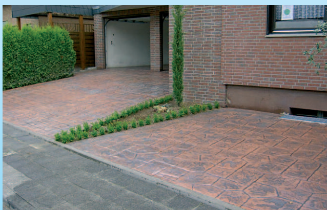
COD. PAVI. 102 • Marciapiede di passaggio per auto
