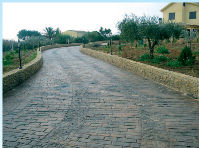
COD. PAVI. 111 • Strada interna
