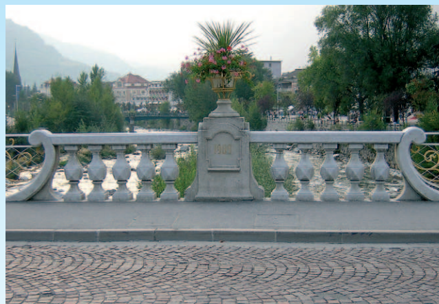
COD. COLO. 058 • Particolare del ponte della Posta di Merano Sciala
