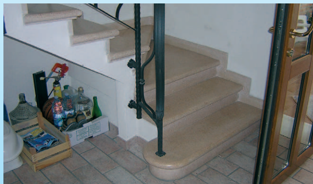
COD. GRAD. 126 • Modello a toro arrotondato cm 5+1 con gradino capo-scala
