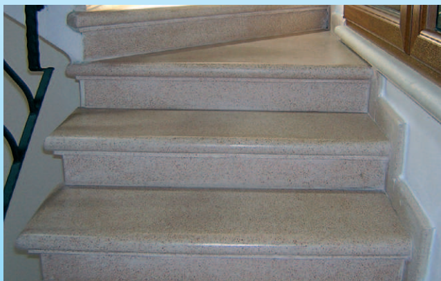
COD. GRAD. 127 • Gradini modello a toro arrotondato cm 5+1 con pedata e alzata
